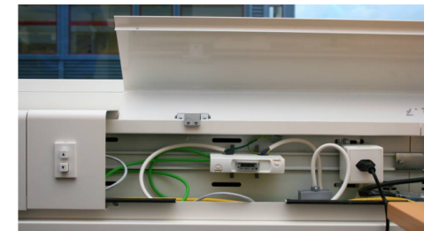
Stromzähler Beleuchtung und Bürogeräte
