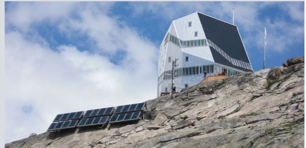
Neue Monte Rosa Hütte
